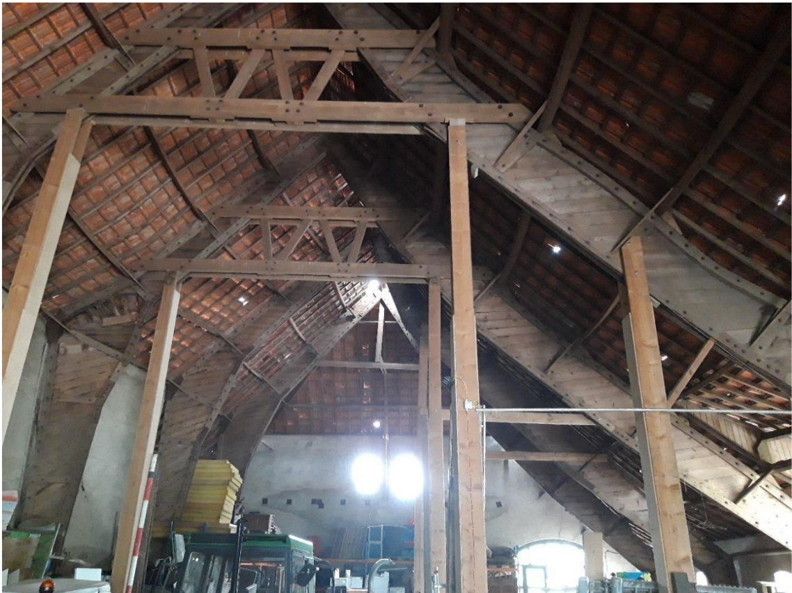
Afbeelding 5. Binnenzijde van de te slopen schuur.
