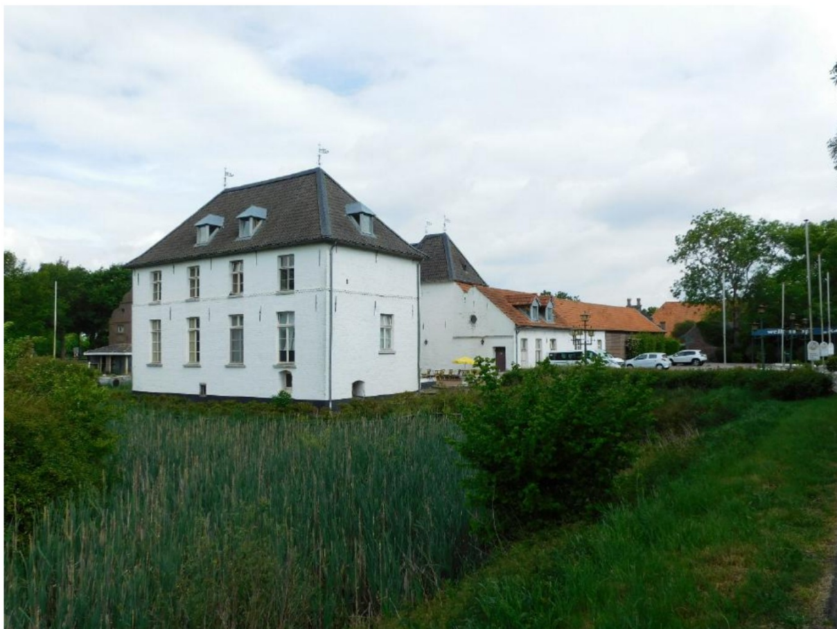
Figuur 4 - Het kasteel van Ooijen tegenwoordig (foto 13 05 2022); links vooraan het oudste gedeelte uit de 15 e -17 e eeuw; daarachter onder het schilddakje met donkere pannen de torenbouw uit de 17 e eeuw; rechts daarvan de vleugel met economiegebouwen uit de negentiende eeuw. De gracht op de voorgrond is in hoge mate dichtgegroeid met riet.
