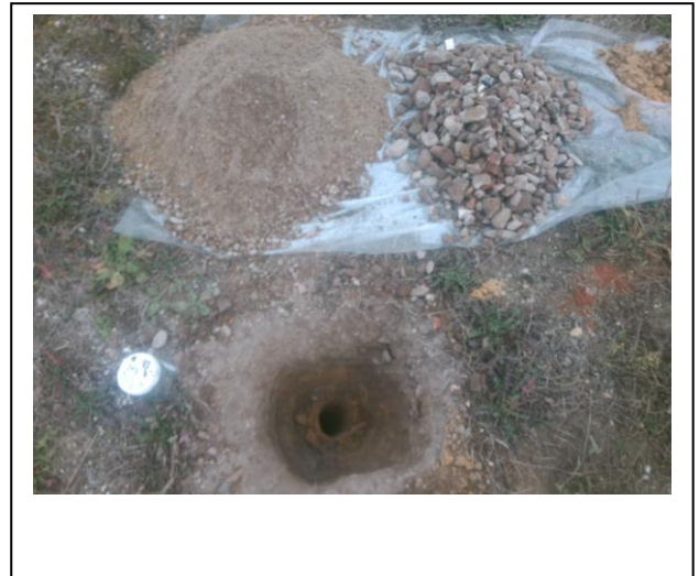
Foto 4. Asbestinspectiegat C4
