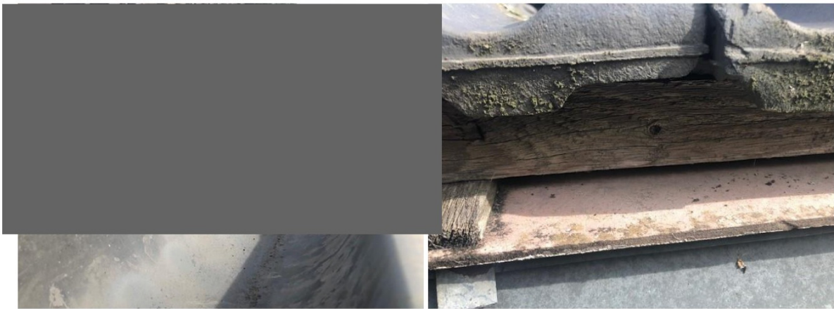
Figuur 4.4.2. Onder de onderste rij dakpannen hebben vogels geen toegang.
