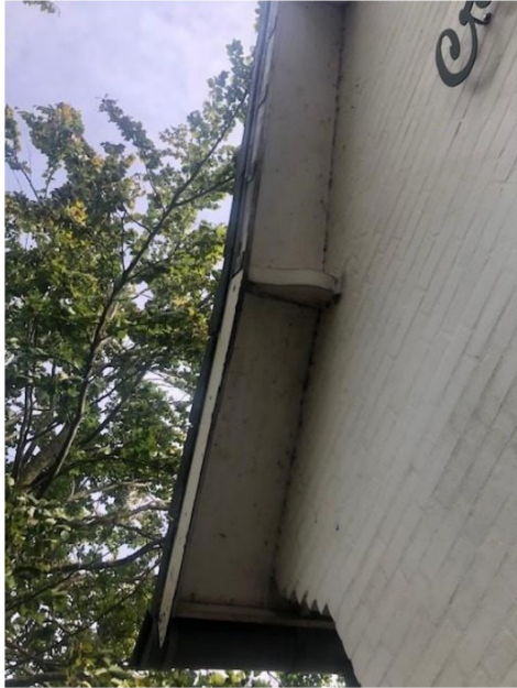
Figuur 4.4.1. De gevelpannen liggen op een gladde trespa plaat.
