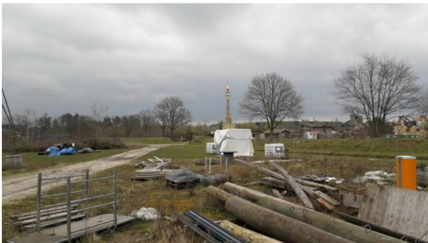
Foto 107: Opslag van diverse bouwmaterialen
