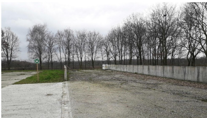
Foto 206: Voormalige voeropslag, met betonverharding
