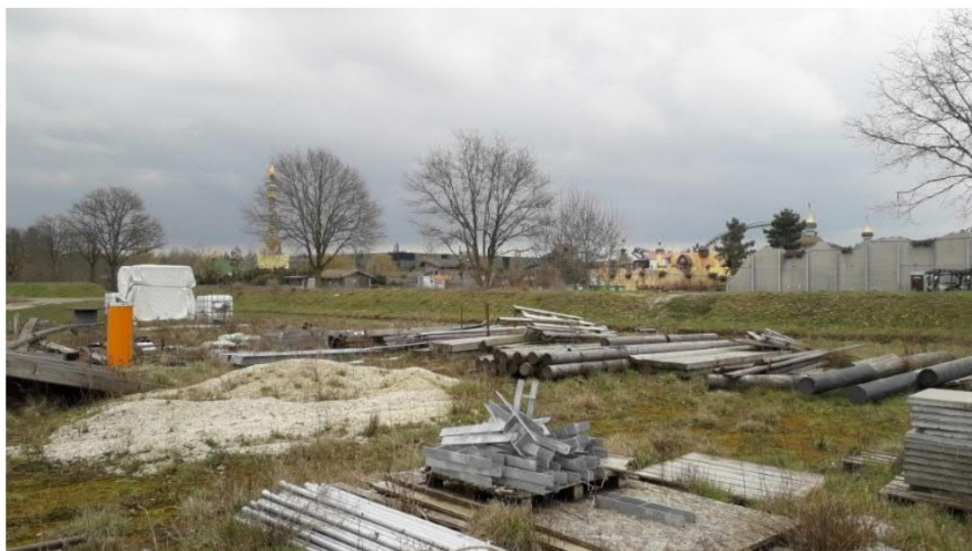
Foto 106: Opslag van diverse bouwmaterialen
