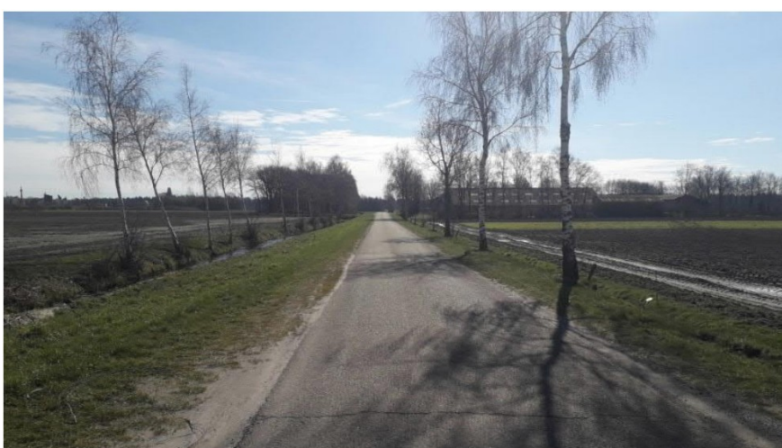
Foto 11: Rijbaan Schorfvenweg (gezien in zuidelijke richting)
