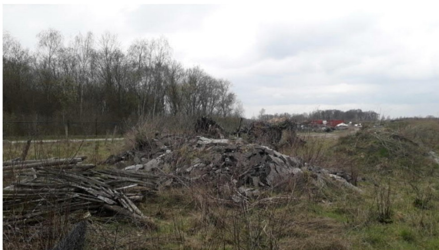
Foto 105: Depot van asfaltchollen afkomstig van tijdelijke verharding op het terrein
