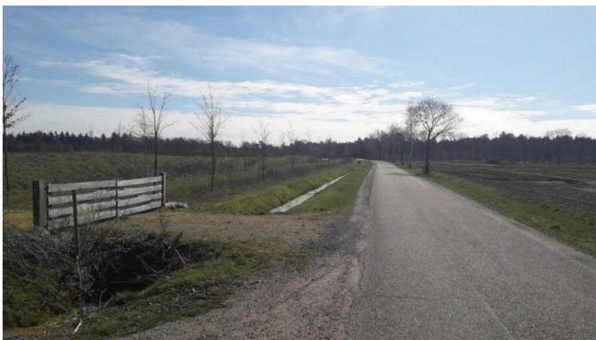
Foto 18: Rijbaan Schorfenweg (gezien in zuidelijke richting)
