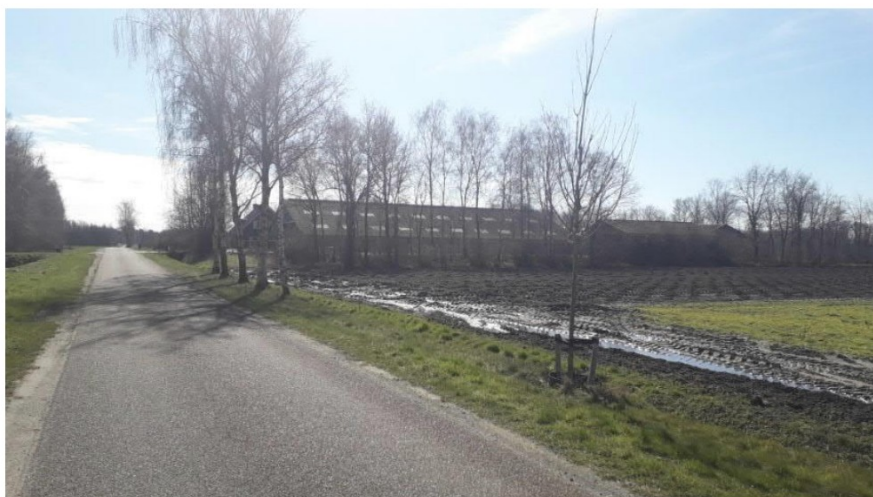
Foto 13: Rijbaan Schorfvenweg (gezien in zuidelijke richting)
