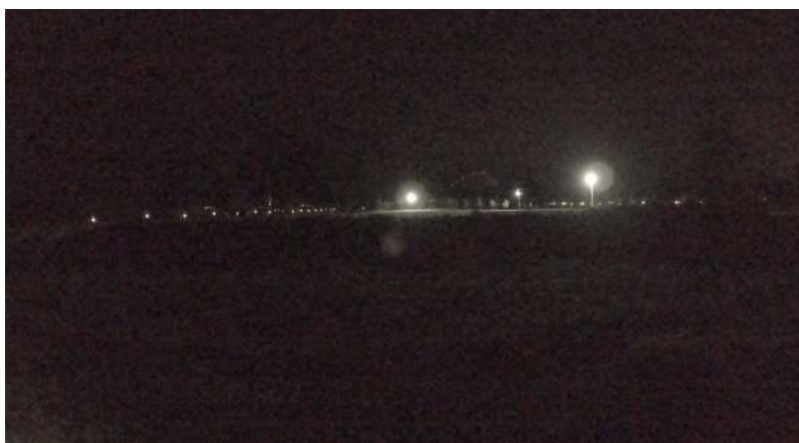
Afbeelding 6: verkeerd afgestelde lichtmasten op het parkeerterrein.
