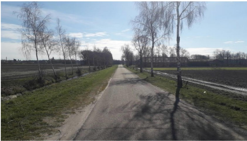
Foto 11: Rijbaan Schorfvenweg (gezien in zuidelijke richting)
