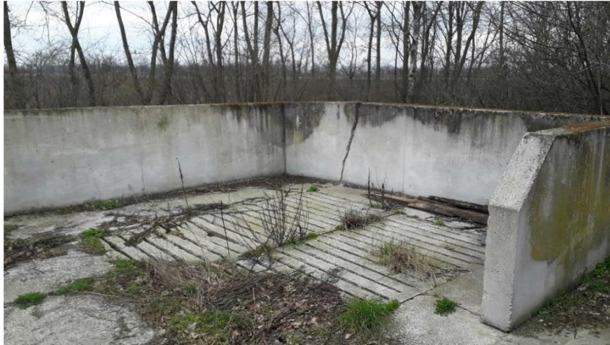
Foto 204: voormalige mestvaalt (alle (gier-)kelders zijn leeggepompt en gereinigd)
