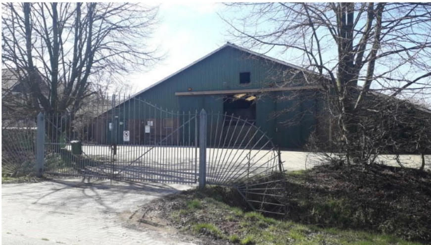
Foto 14: Ingang voormalige boerderij aan de Schorfvenweg 10
