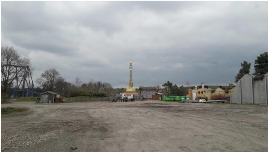
Foto 102: Terrein direct achter het attractiepark (laagje zand, met hieronder waarschijnlijk dunne laag puin/menggranulaat)
