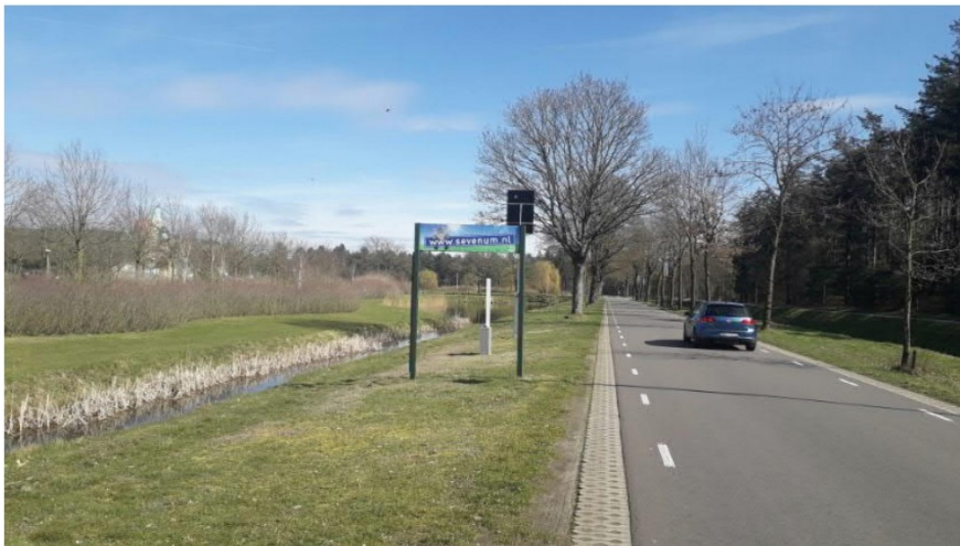
Foto 23: Rijbaan Helenaveenseweg (gezien in oostelijke richting)
