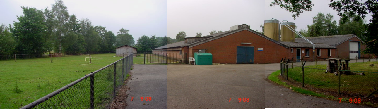
Foto 1: Compositiefoto gezicht vanaf de oprit Roothweg 1 te Meterik met links dierenweide en rechts twee kippenschuren richting zuiden.
