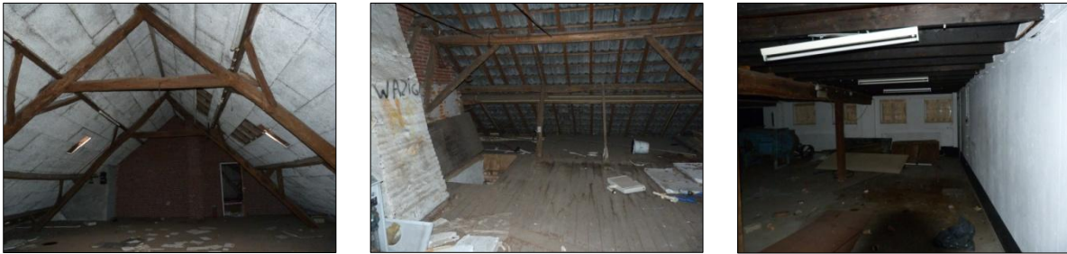
Figuur 5, 6 en 7. Enkele overzichtsfoto's van de te slopen boerderij aan de binnenzijde.
