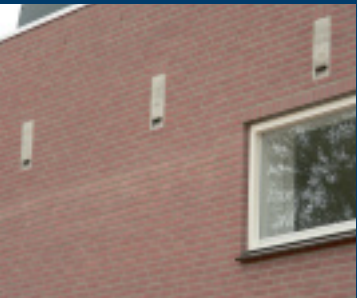
Boven: inbouwen van een verblijfplaats voor vleermuizen
