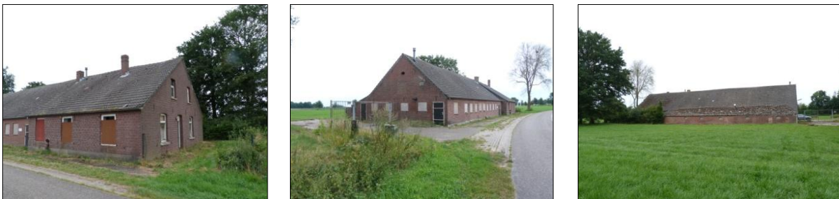
Figuur 2, 3 en 4. Overzichtfoto's van de te slopen boerderij aan de buitenzijde.
