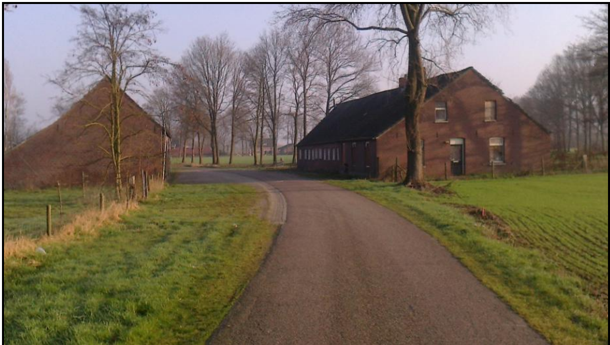
Afbeelding 5: aanzicht zuidzijde huidige bebouwing
