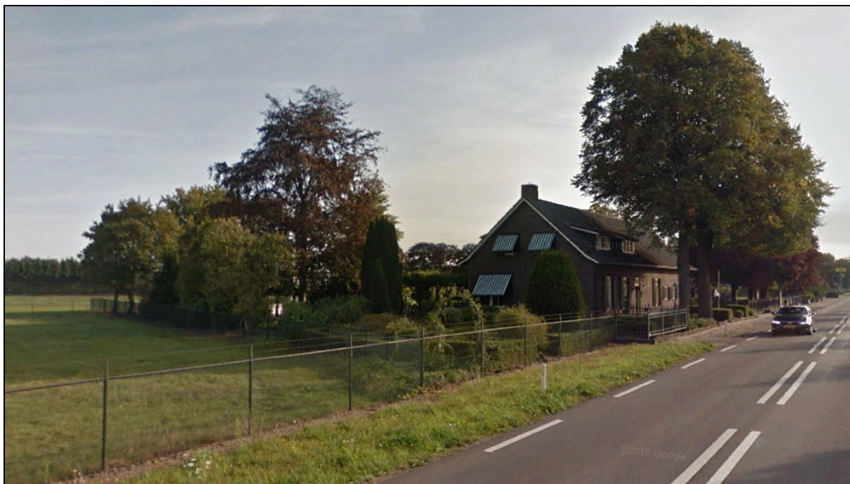
Afbeelding 4. Zicht op woning vanaf Horsterdijk
