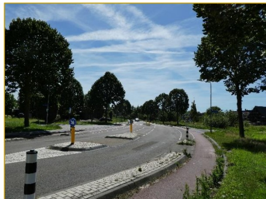
Afbeelding 3. Beoogde locatie rotonde (zuidelijk geörienteerd).
