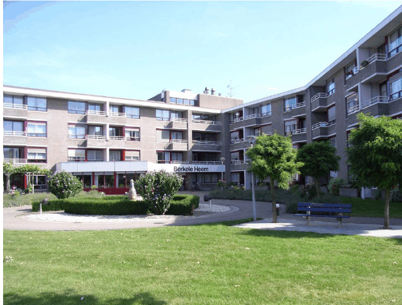
Afbeelding 2: Verpleegtehuis Berkele Heem in het plangebied Hof ten Berkel (bron: Ecologica).
