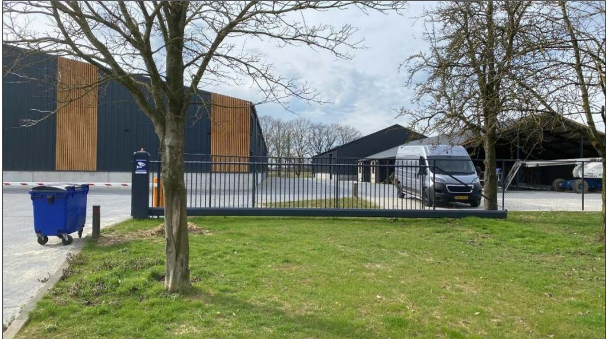
Figuur 6: Aanzicht voorzijde nieuwe bebouwing, Bestaand groen behouden en toepassing van hoogwaardige materialen
