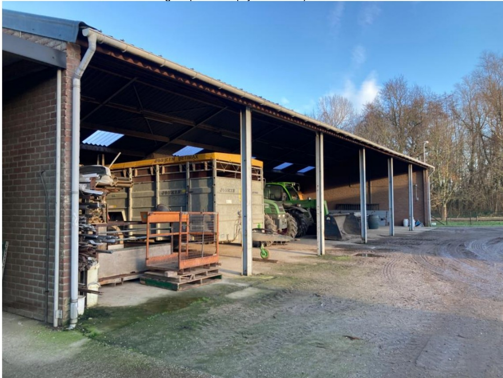
• Afbeelding 4: open loods (blijft behouden)
