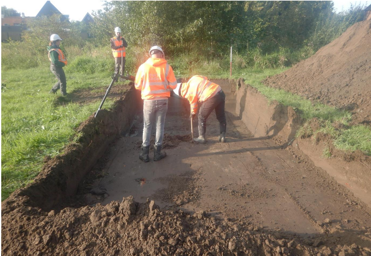
Figuur 4.3 Detectie van mogelijke Ontploffbare Oorlogsresten (OO) door Euroradar
