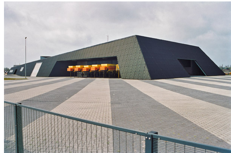
Steunpunt Rijkswaterstaat, Harlingen (NL) Neutelings Riedijk Architecten
