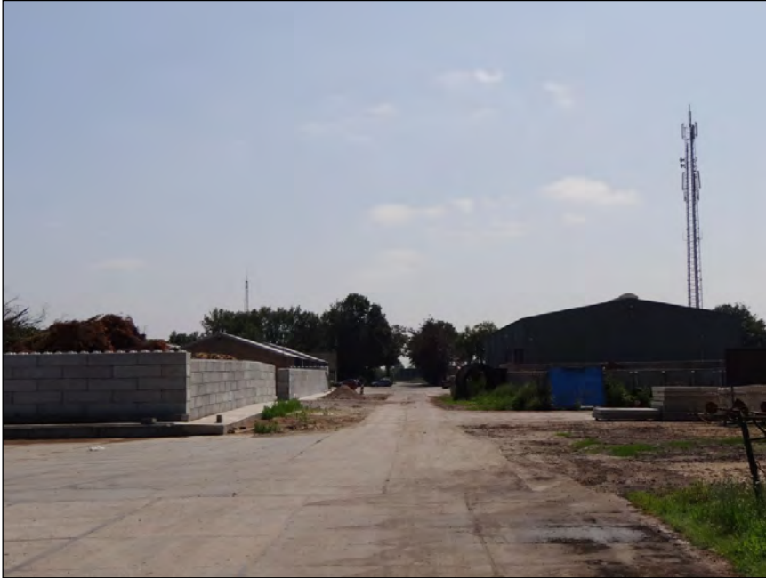
Afbeelding 7: De projectlocatie gezien vanuit het noorden
