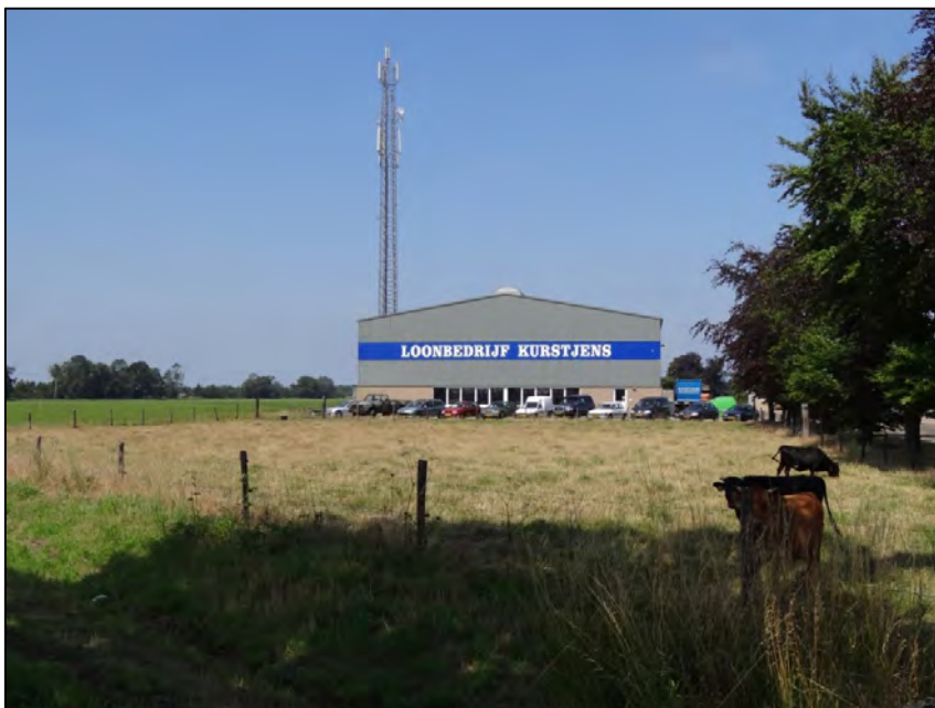
Afbeelding 16: De bestaande loods krijgt een nieuw front, gevormd door een kantoor met een representatieve uitstraling
