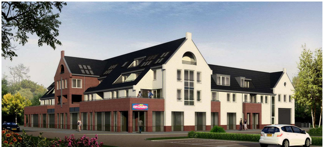
Figuur 5: gevel de Zumpel
