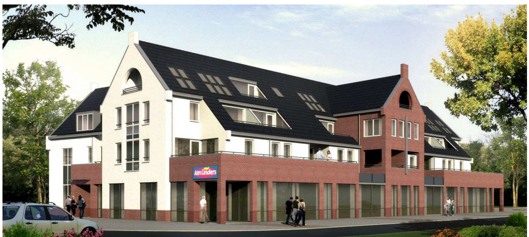
Figuur 6: gevel Julianastraat
