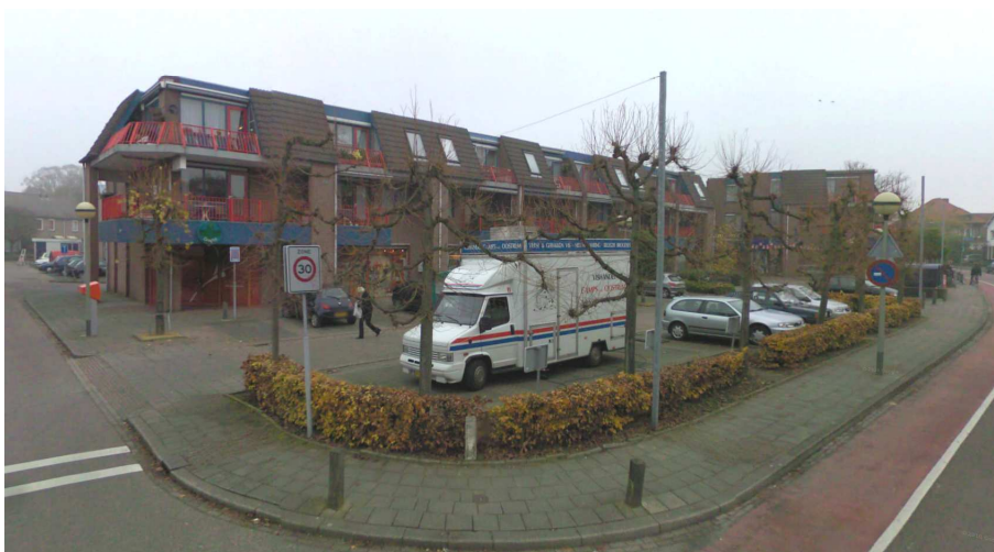
Figuur 1: gevel Zumpel voor renovatie
