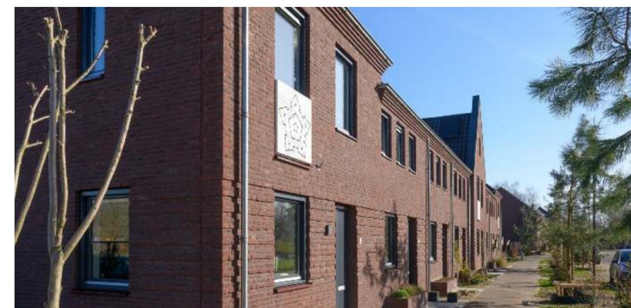
verspringing in de gevel
