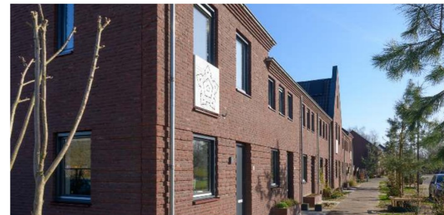
verspringing in de gevel
