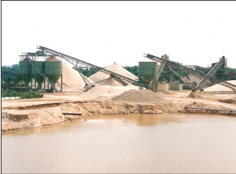
Figuur 3.10 Voorbeeld van een verwerkingsinstallatie
