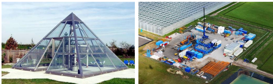
figuur 3. Links: voorbeeld permanent pomphuis in Erding (Dld, bron: platform geothermie). Rechts: de tijdelijke boorinstallatie op de boorlocatie van Californië Wijnen Geothermie BV.
