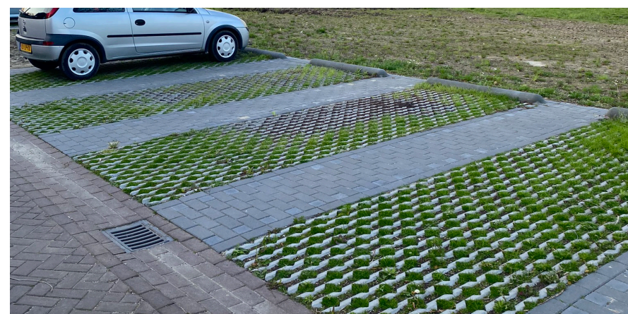
parkeervakken buiten het lint worden uitgevoerd in grasbetonstenen
