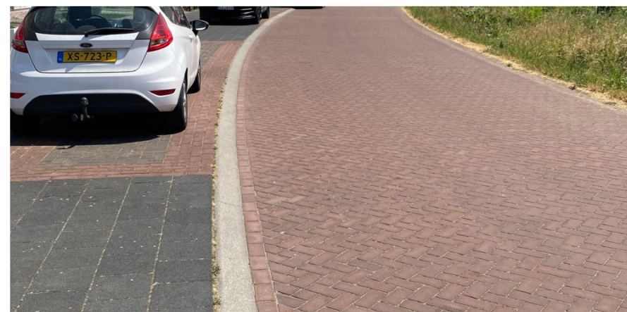
rijloper in keiformaat roodbruin, parkeervakken langs het lint geduid in een donkerdere steen. trottoirs in 30x30 betontegels
