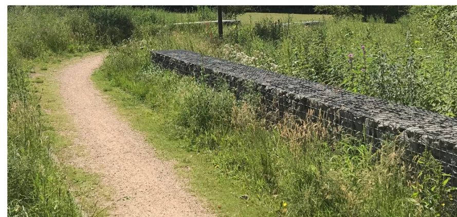
wandelpaden langs en tussen het erf en wooncluster worden uitgevoerd in halfverharding
