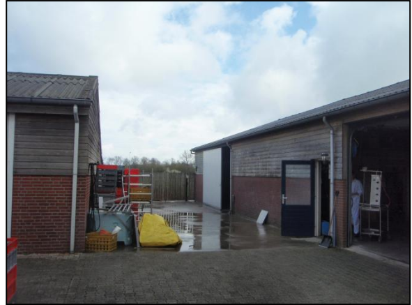
Afbeelding 7. Te bebouwen ruimte tussen slagerij en werkplaats
