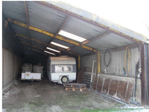
Aanbouw bij loods 3
