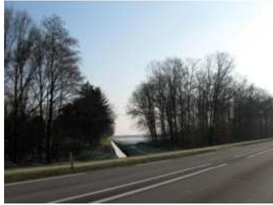
Zicht op Aanvoerleiding tussen bos en bosstrook
