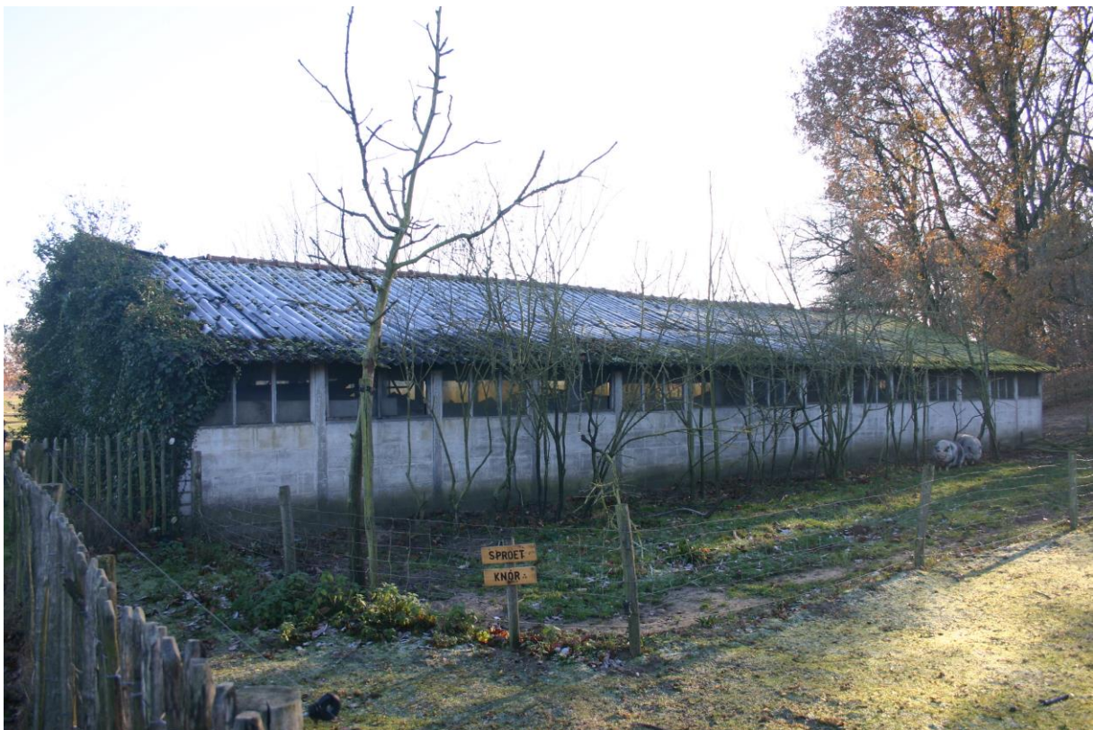
Figuur 9. De deels te slopen schuur.
