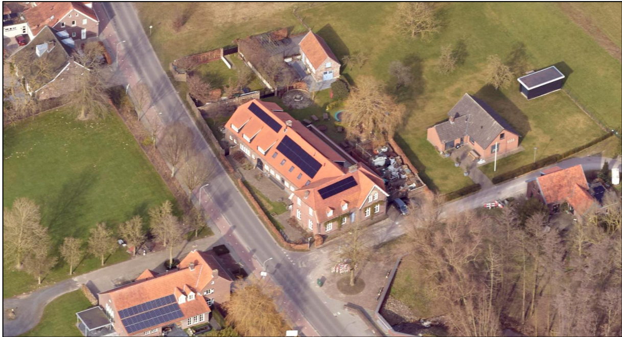
Afbeelding 3. Luchtfoto van de woning Molenberg I
