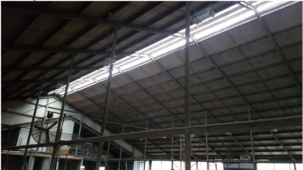
Foto 16: binnenzijde grote veestal N.B. is de ventilatienok open en zaten hier veel huismussen.
