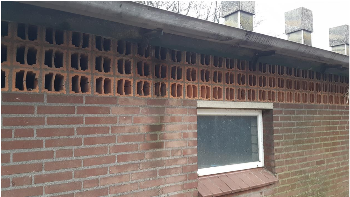
Foto 13: open nehobo ventilatiestenen in de westgevel.
