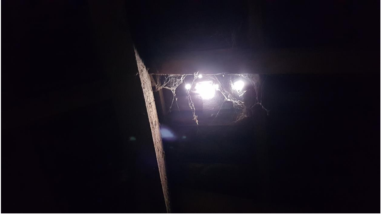
Foto 9: gaten in het dak.
