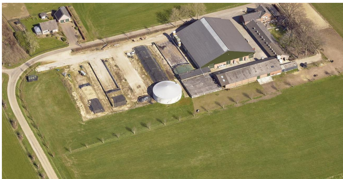
Figuur 1: de onderzoekslocatie.
