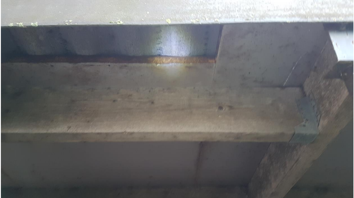
Foto 21: dakrand hangt over de zijkanten. Kleine ruimtes tussen het dakbeschot en golfplaten.
