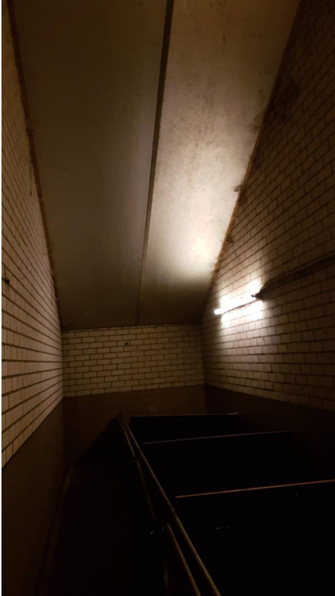
Foto 12: afwerking aan de binnenzijde van voormalige biggen batterij welke goed afgesloten is.
