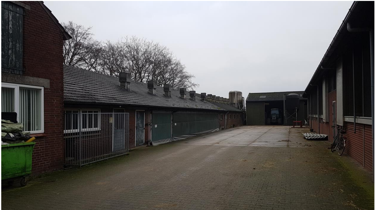
Foto 5: de deels te slopen varkensstal links en de veestal rechts. De varkensstal blijft tot aan de eerstedeur.
