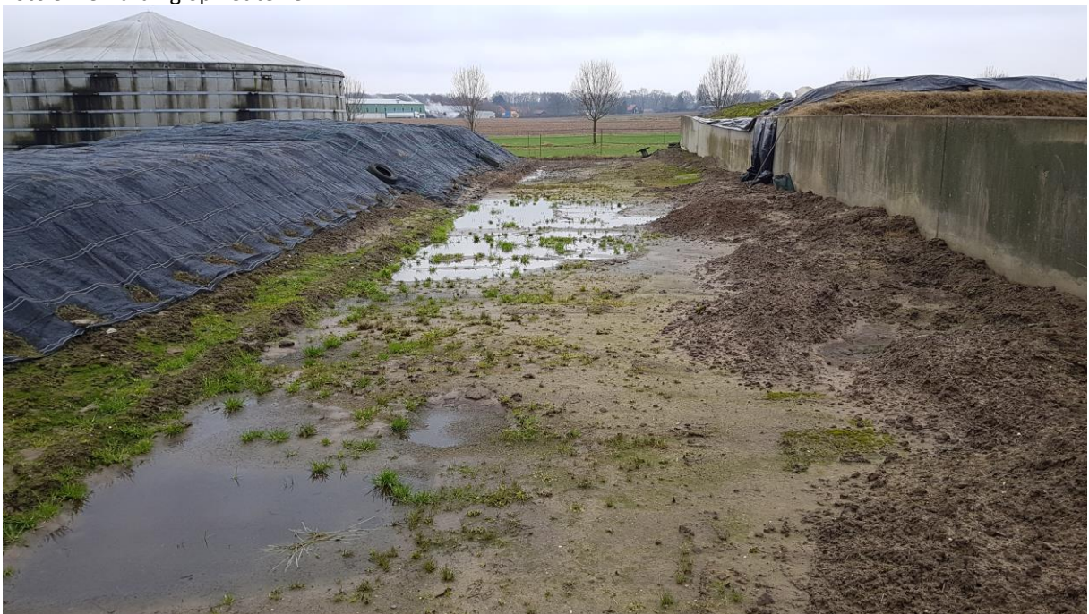
Foto 4: onverhard tussen de kuilvoerplaten. Met links het te slopen mestbassin
