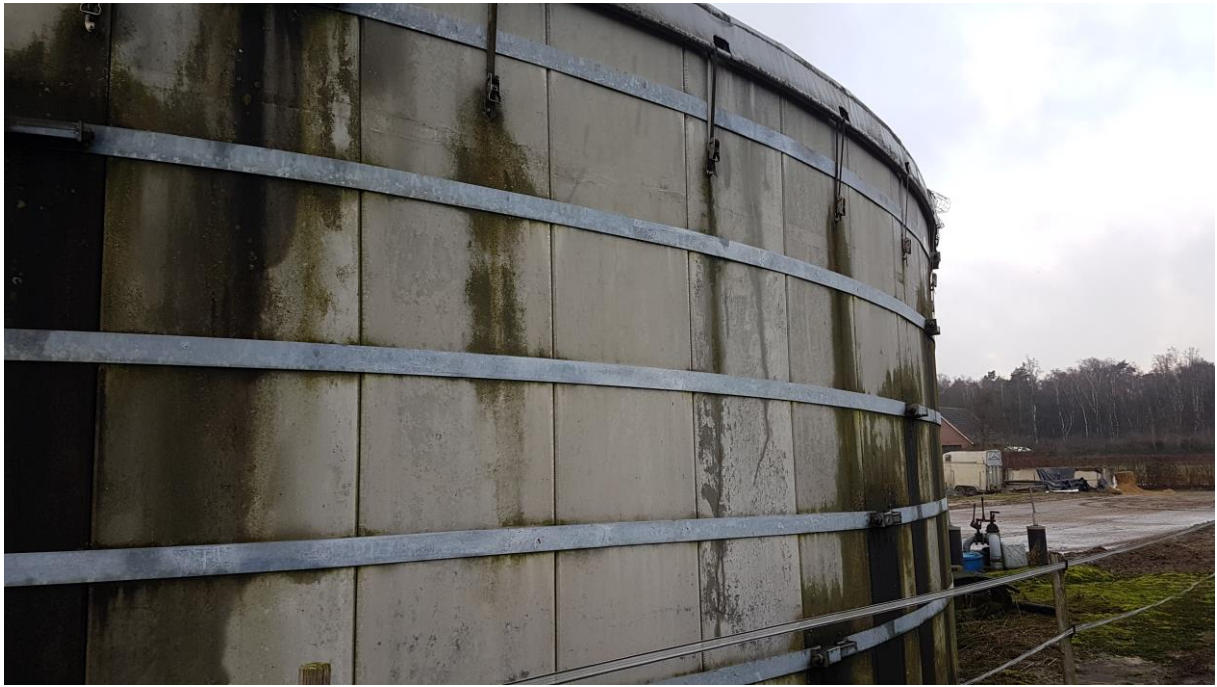
Foto 23: het te slopen mestbassin.
