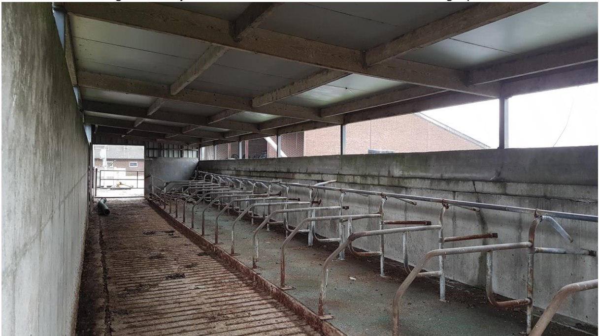
Foto 22: binnenzijde van de aangebouwde en te slopen veestal met roosters naar het mestbassin.
