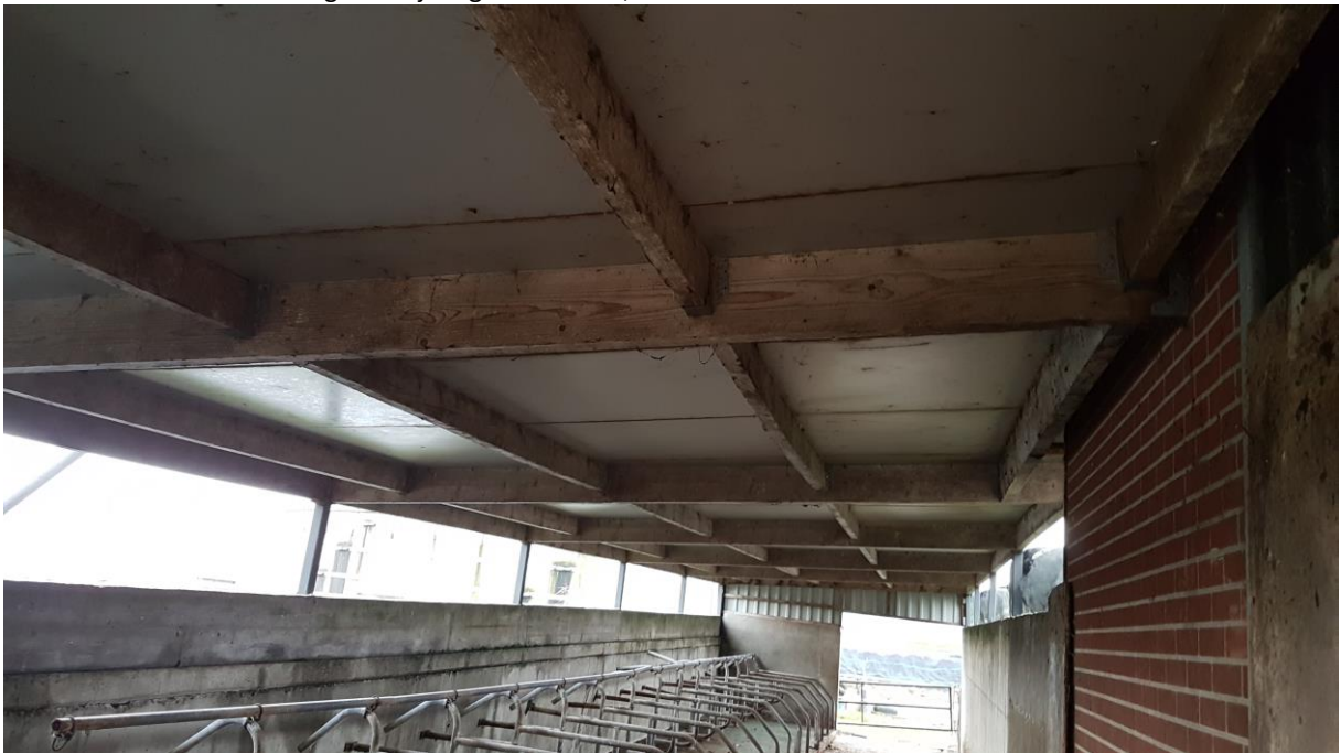
Foto 20; de aangebouwde en te slopen veestal vanaf het oosten.
