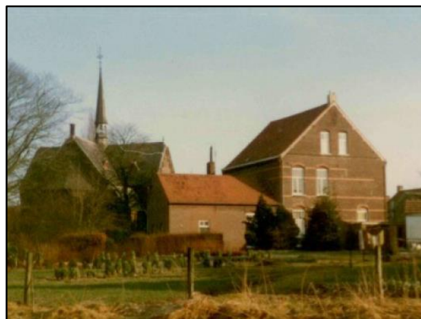
Afbeelding 13. Zicht op het pand vanuit de voormalige kloostertuinen
