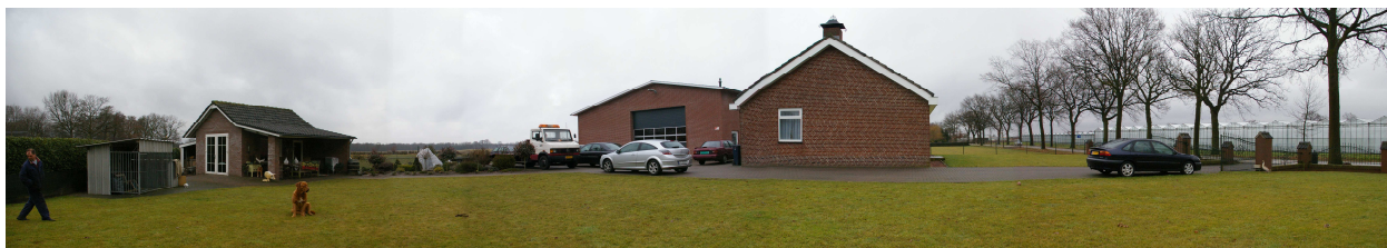
afbeelding 7. Huidige situatie. Linkerzijde perceel gezien vanuit Hofweg 19
